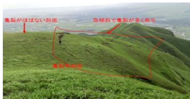
写真2 熊本地震後に生じた地割れ（H28年5月撮影,南阿蘇村）
